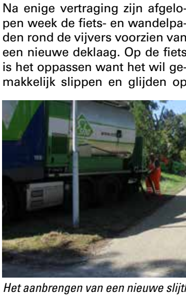
Het aanbrengen van een nieuwe slijtlaag. (foto: Marten de Vries)
