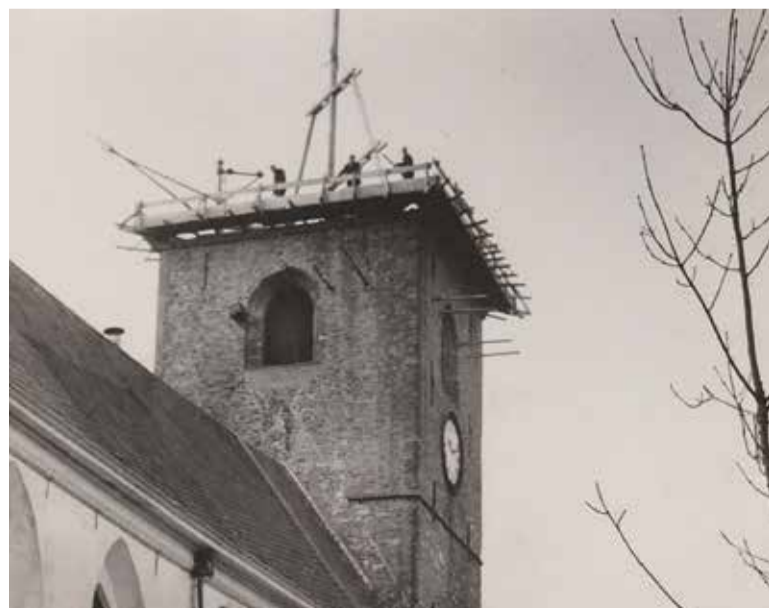
Op 26 maart 1957 verscheen deze foto in de pers met als onderschrift: “Maandenlang bood de toren een trieste aanblik. Sedert enige tijd is men bezig met het herstel. Gistermorgen kon het geraamte van de spits omhoog getrokken worden. Om dit geraamte zal de spits opgebouwd worden. Zo komt de dag in zicht, dat de sporen van de rampzalige brand weer verdwenen zullen zijn.”
