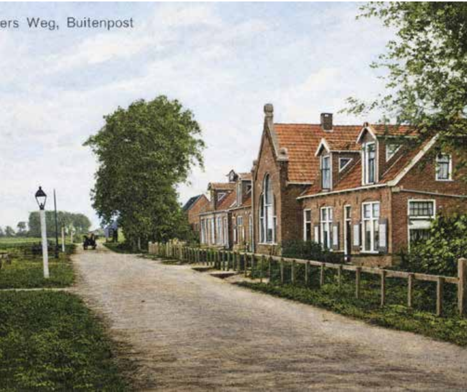
↑ Rond 1920 – Kuipersweg Alleen de verste twee van de nutswoningen naast het Nutsgebouw staan er nog. Op de plek van de eerste vier huisjes en het Nutsgebouw is nu de grote parkeerplaats tegenover het Innovatiehuis te vinden.
