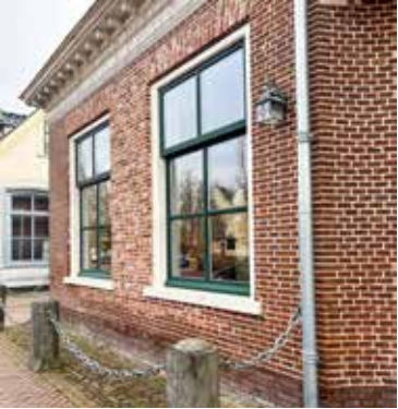
De voorgevel van het pand.
