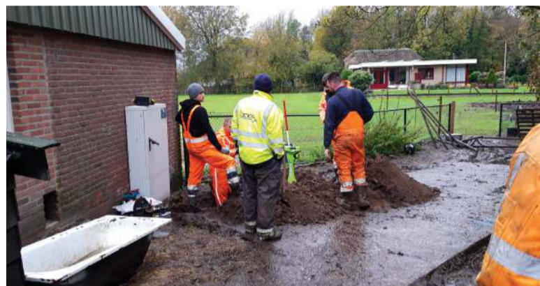
Er wordt geboord voor de netaansluiting.
