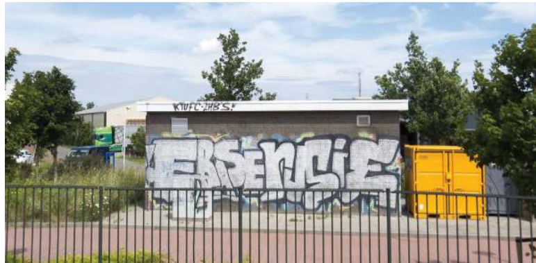
Elektriciteitshuisje bij het station.
