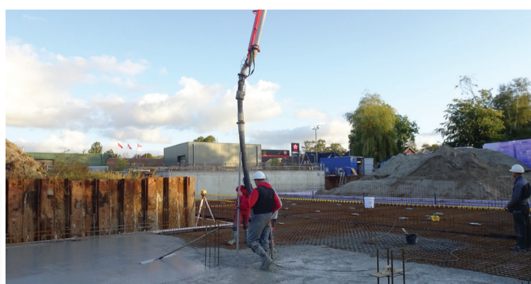
Op 24 september reden betonwagens af en aan om de vloer van het nieuwe zwembad te storten. (foto: Hielke Boorsma)
