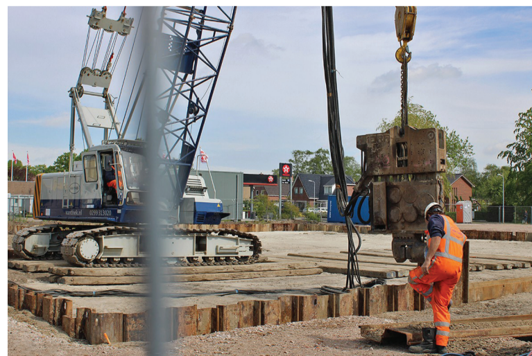
Uitvoering grondwerk voor het nieuwe zwembad.
