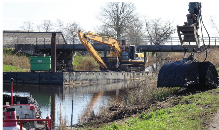
Het werk is begonnen met het uitbaggeren van de vaart ter hoogte van de spoorbrug.
