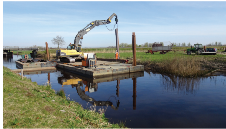
Vervolgens werd een stalen beschoeiing geplaatst. (foto's: Hielke Boorsma)
