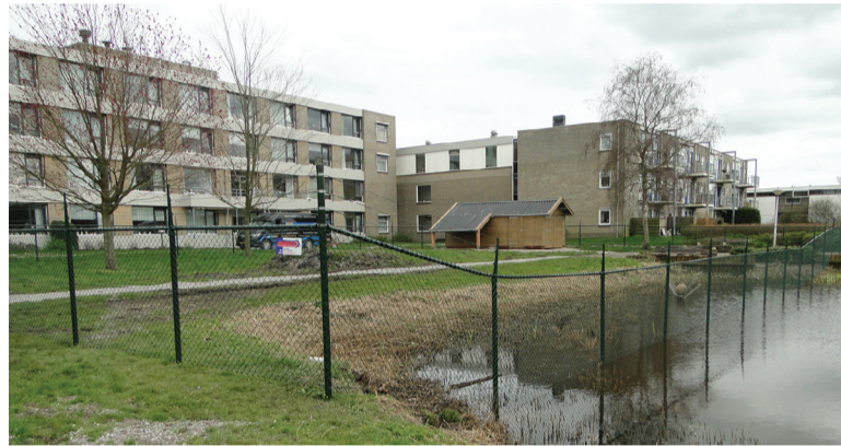
Het dierenverblijf en het hekwerk zijn geplaatst.
