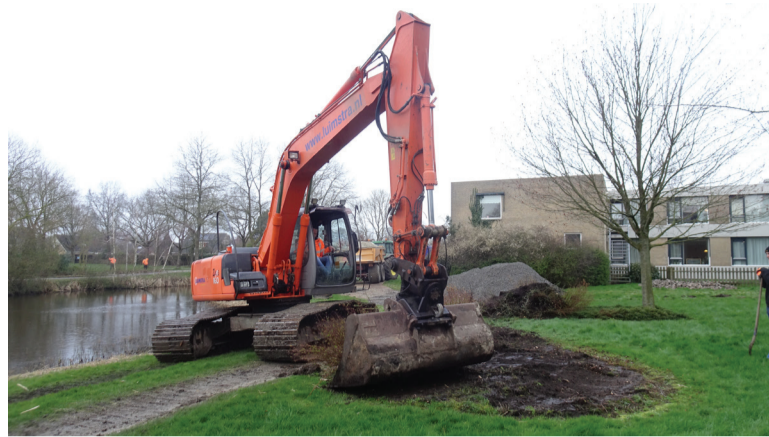
Start van de werkzaamheden.
