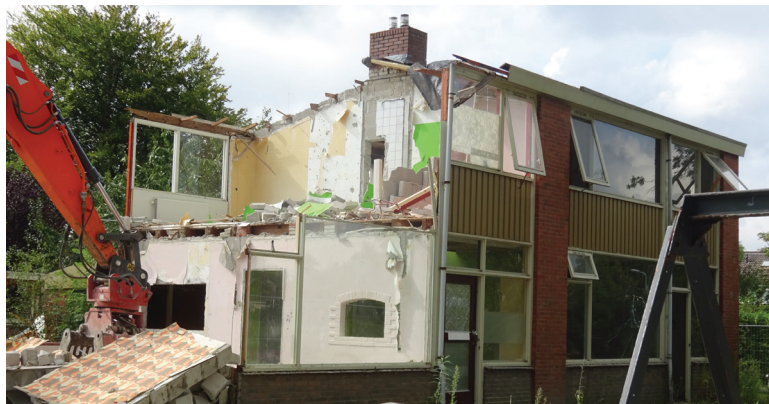
Sloop in de Halbertsmastraat.
