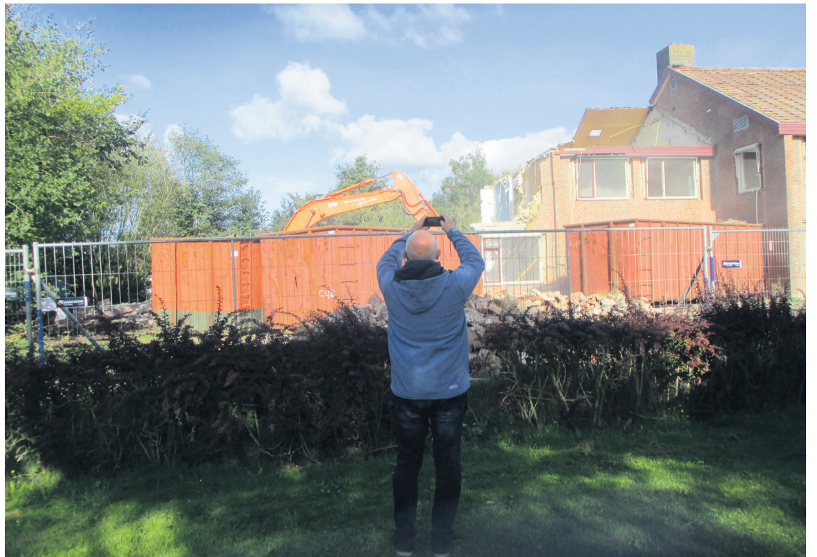
Johan legt de sloop vast (foto: Nelleke Kemps)
