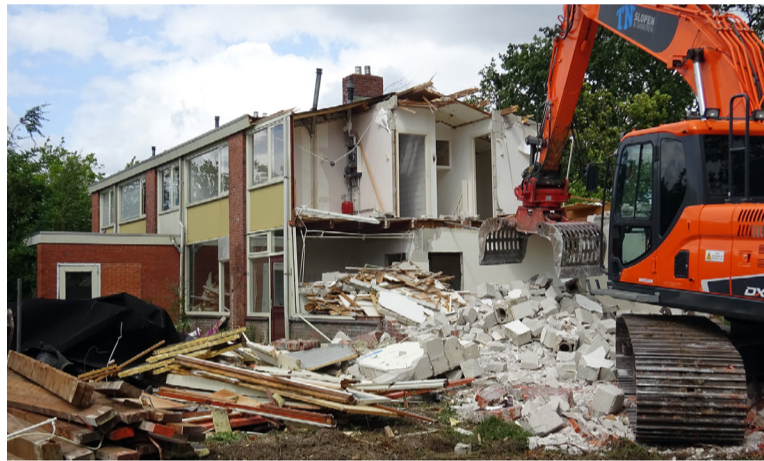
De in 1963 aan de Halbertsmastraat gebouwde woningen worden 56 jaar later afgebroken om plaats te maken voor 20 zogenaamde levensbestendige huizen. Op 19 augustus is begonnen met de sloop. De bewoners van de vier nog bewoonde woningen zijn niet blij met de (stof)overlast. (foto: Hielke Boorsma)
