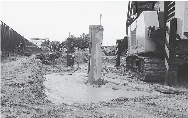
De eerste palen van de voetgangersbrug zijn geplaatst, de gaten waren geboord tot een diepte van negen meter. (foto: Hielke Boorsma)
