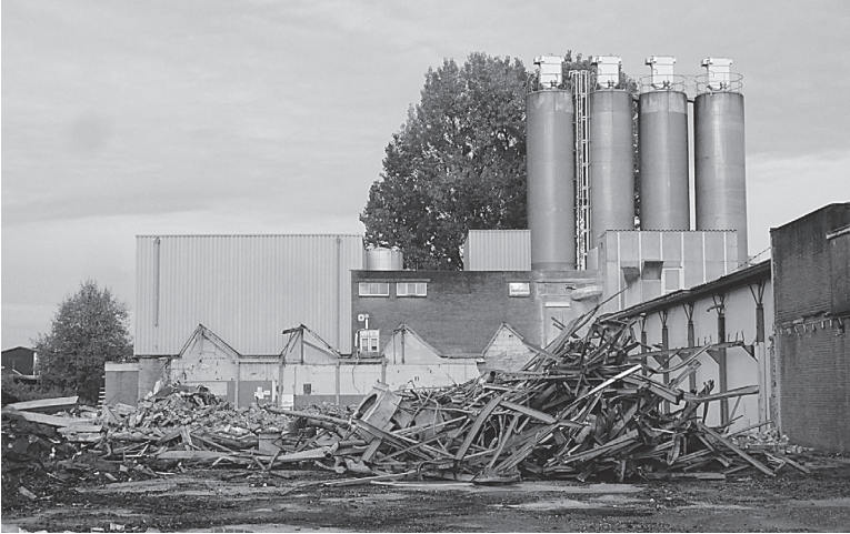
Het oude pand van de Enitor (nu Essentra) aan de Beatrixstraat is gesloopt. In week 45 gaat de eerste paal van de nieuwbouw de grond in. (foto: Hielke Boorsma)
