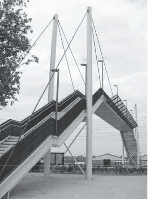
Voorbeeld van de brug over het spoor.
