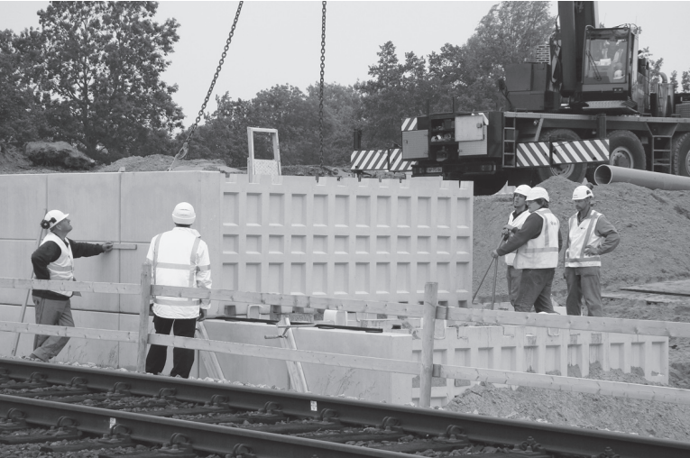
De firma Bam bouwt momenteel aan het viaduct, in de rondweg. Bij de Paralelleweg worden betonblokken van z’n 3500 kilo op elkaar gestapeld, waarna de tussenruimte met zand word opgevuld. (foto: Hielke Boorsma)
