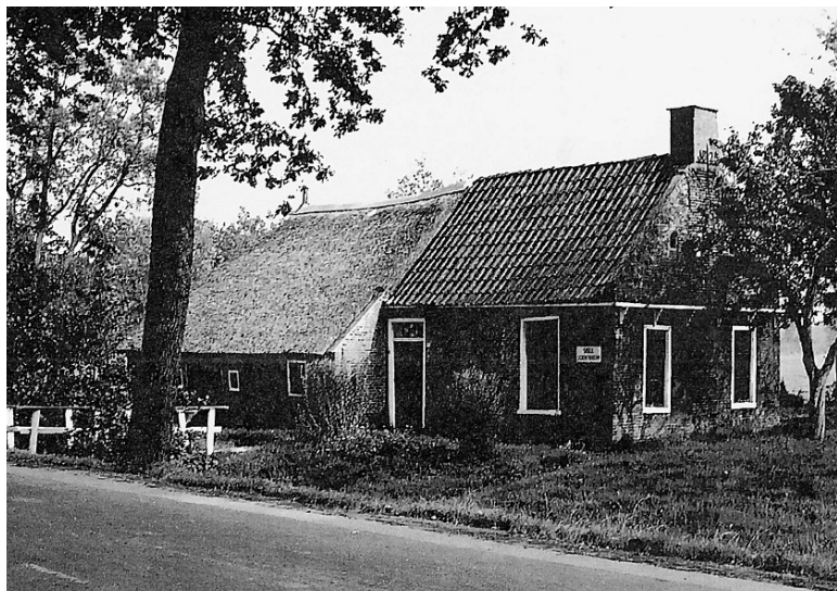
Pand in het West (destijds huisnummer 129) te Buitenpost. Afgebroken in 1958. (foto: uit het gemeente-archief)
