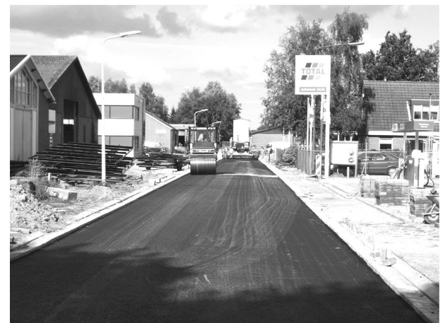
Mooi overzicht van de Marconistraat, hier wordt de eerste laag asfalt aangebracht. Aan de rechterzijde wordt de bestrating reeds aangebracht door Spoelstra bestratingen.
