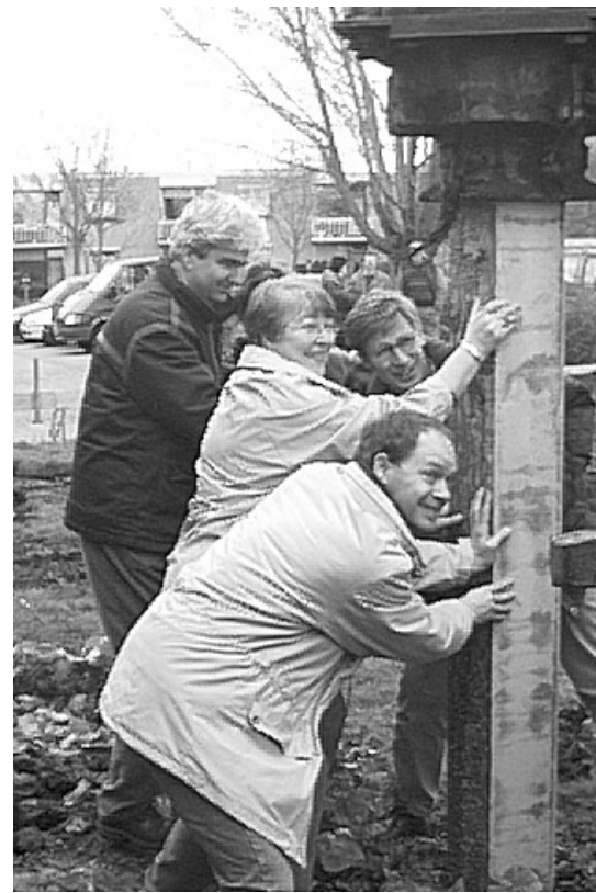
Het huisartsentrio Kok, Kruyt en van der Steen samen met wethouder Hieke Postma symbolisch in de weer met het eerste deel van het fundament. Onmiddellijk duidelijk is wie van de drie net om de hoek komt kijken in Buitenpost.
