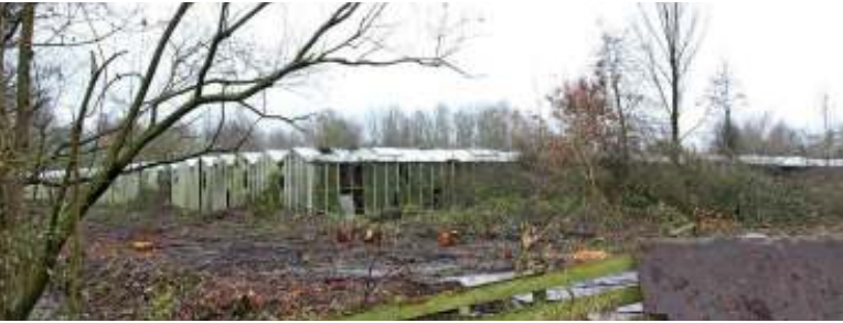
Het kassencomplex aan de Keurloane.
