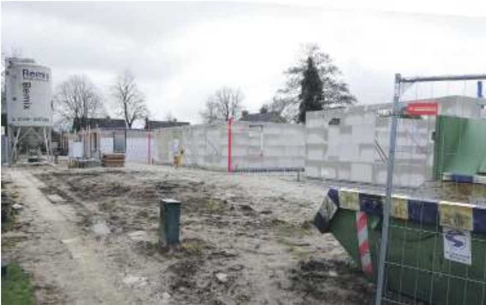
Op de bouwplaats van de 15 nieuwe huizen aan de Halbertsmastraat gaat het vlot. Bij de eerste woningen, grenzend aan de Mejontsmastraat, ligt de verdiepingsvloer er al op en wordt aan de buitenmuur gemetseld. Hopelijk volgt er snel meer nieuwbouw. (foto: Hielke Boorsma)
